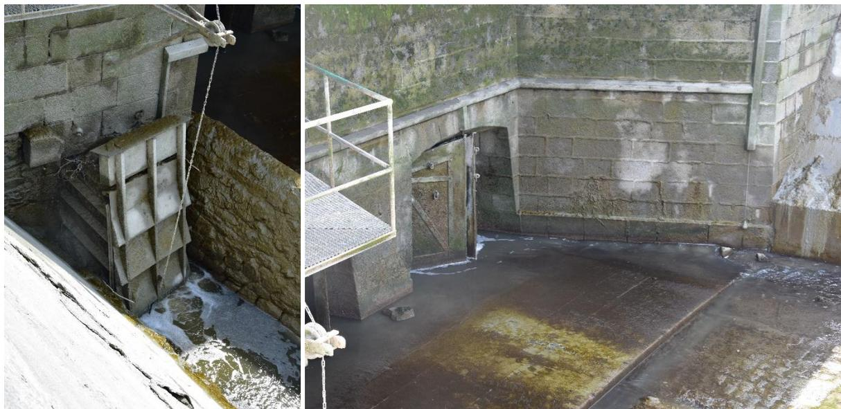
*Figure 4 : Clapet (à gauche) et porte à flots (à droite) à l'exutoire des côtiers de Dol*
